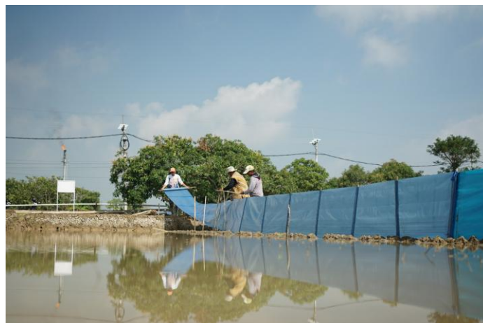
Gambar 3. Pemasangan Trap Barrier System (TBS) di lahan sawah Sumber : Dokumentasi Perusahaan, 2026
